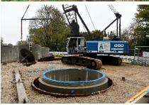
Der Brunnen wächst in die Tiefe: Per Kran wird der erste Betonring in den Schacht gehoben. Dann wird das Erdreich innen ausgebaggert, der Ring sinkt ein und das nächste Element wird aufgesetzt – bis der Brunnen gut 20 Meter tief ist.
